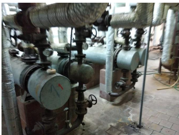
Obr. č. 7 – Výměníky – VS poliklinika
