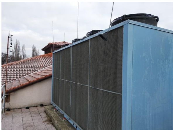
Obr. č. 5 – Chladicí jednotka Kappa
