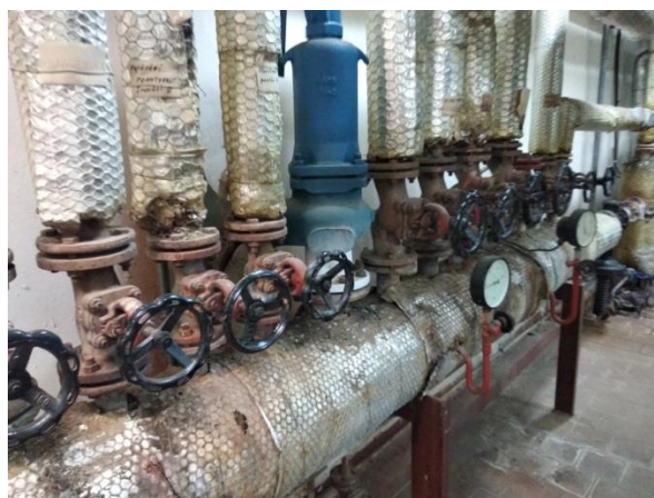
Obr. č. 8 – Parní rozdělovač – VS poliklinika
