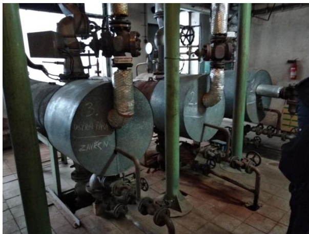
Obr. č. 10 – Výměníky pára/topná voda instalované ve VS hlavní pavilon
