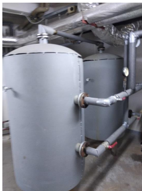
Obr. č. 12 – Akumulace TV – VS přístavba
